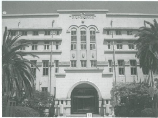
残される玄関アーチ
